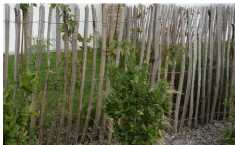
Figure 13 : Exemple d'une clôture de type ganivelle
