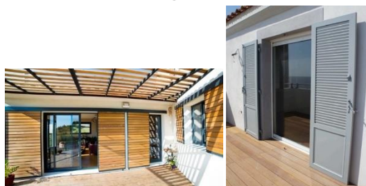
Figure 9 : Exemple de volets bois (battants ou coulissants)
