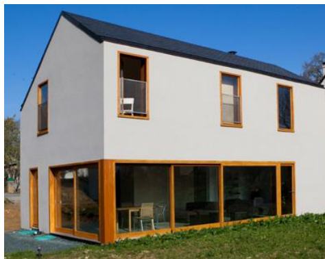
Figure 1 : Exemple d'une construction en maçonnerie
