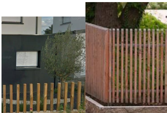
Figure 12 : Exemple de clôture de type bastaing bois ou de type pin autoclave
