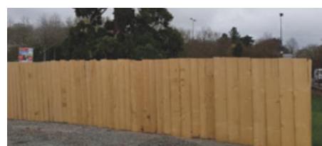
Figure 5 : Exemple de clôture de protection pleine mise en place
