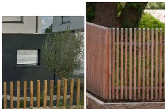
Figure 4 : Exemple de clôture de type bastaing bois ou de type pin autoclave
